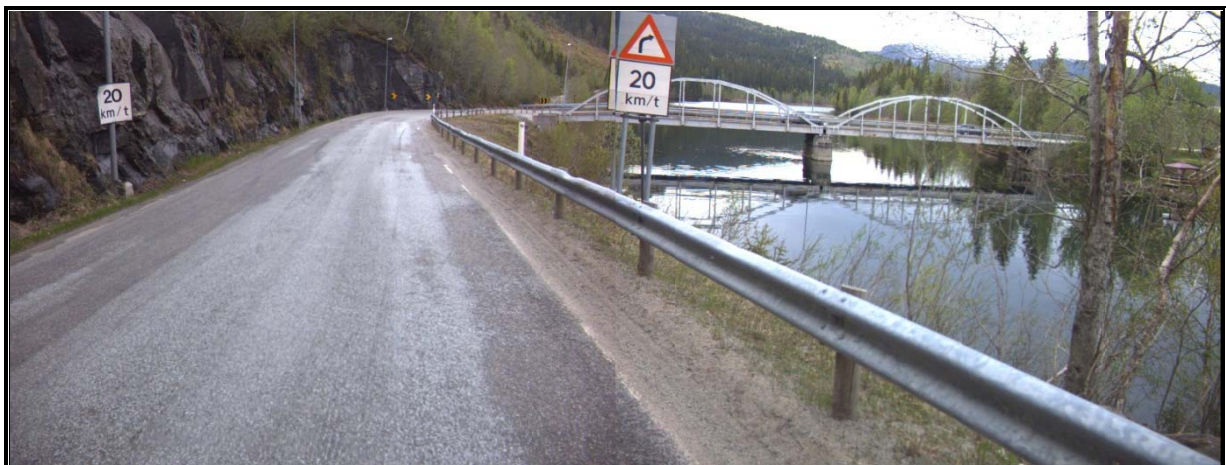
Eksisterende Langvassåga bru ved Røssvoll.
